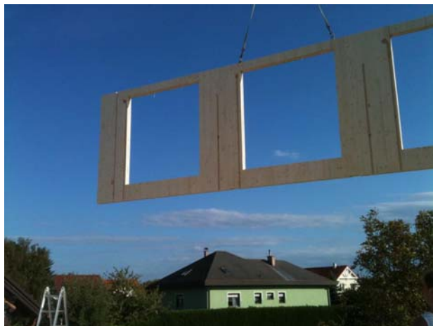
CLTによる戸建住宅(建築中)
